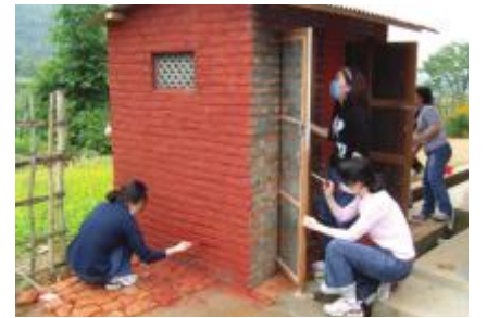
인도네시아 취약계층 지역 화장실 건립공사(2015.11.20.)
