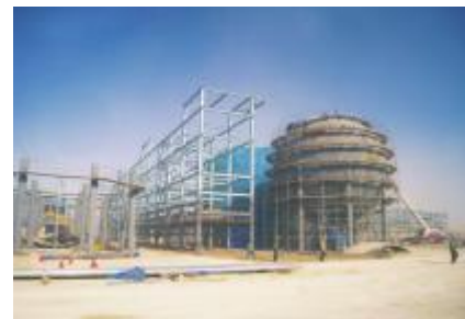
수르길 가스전 개발 및 화학플랜트 건설 프로젝트(2012. 3. 26.)
