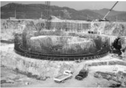
경수로 공사 현장(1998.)
