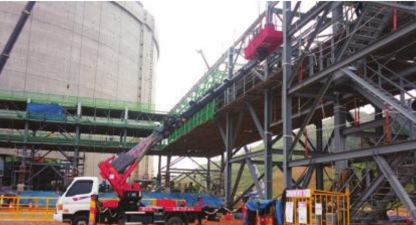
보령 LNG 수입터미널 건설 지원(2014. 12.)
