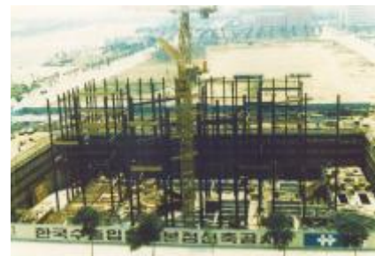
본점 신축 공사(1983.)
