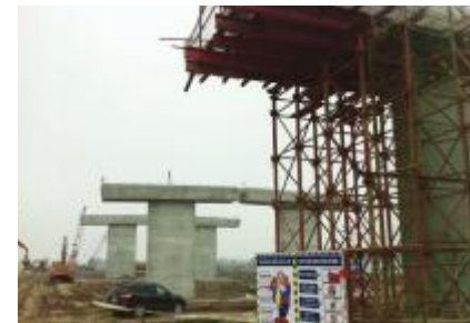
베트남 하노이 하이퐁 7공구 탄안교량 건설사업 현장
