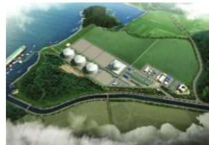
보령 LNG 터미널(조감도) 금융지원(2014. 12. 23.)
